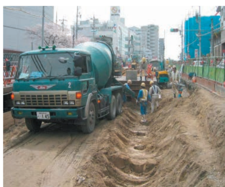
▲ 親杭鋼矢板 H 鋼抜柱後の充填工
