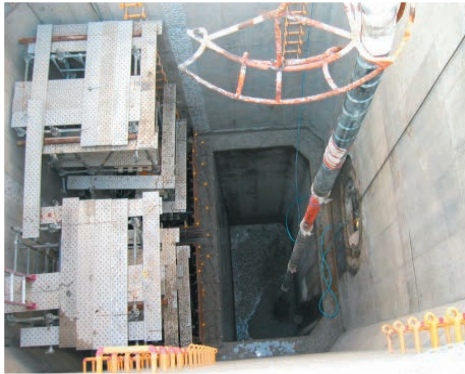
▲ 中詰土砂の代用 発進立坑埋め戻し工
