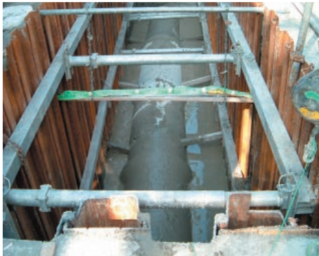
▲ 下水道管理め戻し工
