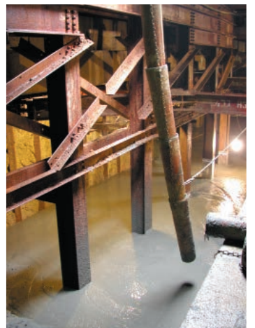
▲ 地下鉄駅舎部埋め戻し工
