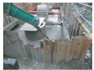
ミキサー車より直接打設
