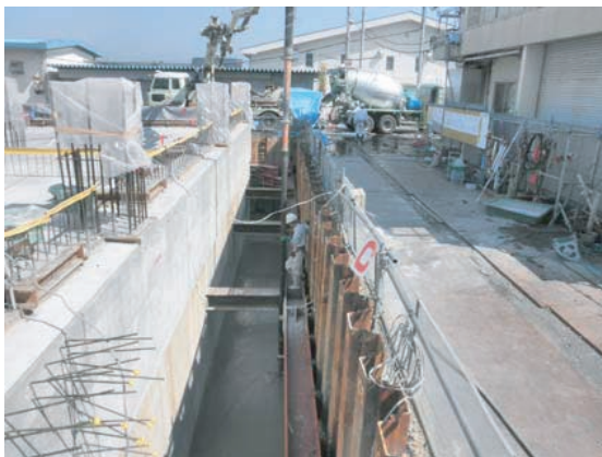
山留・躯体との間の埋め戻し
