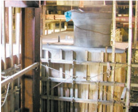
▲ 下水道雨水管整備工事 人孔埋め戻し工
