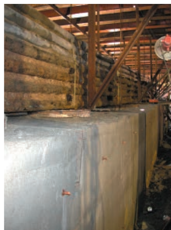
▲ 多条保護管の受け防護工
