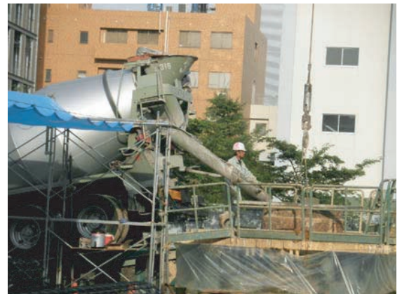
既設杭撤去後の埋め戻し
