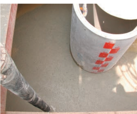
▲ 人孔周辺部の埋め戻し工
