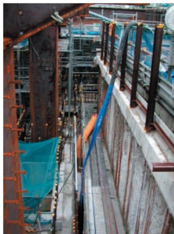
▲ 建築躯体側部の充填
