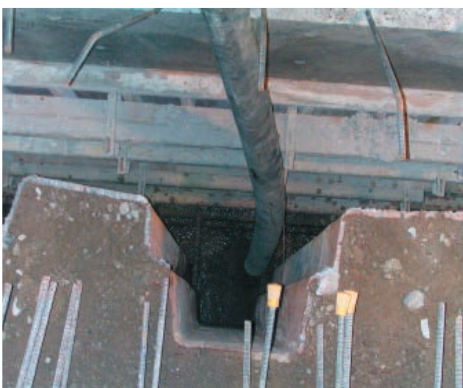
▲ 矢板側部埋め戻し工
