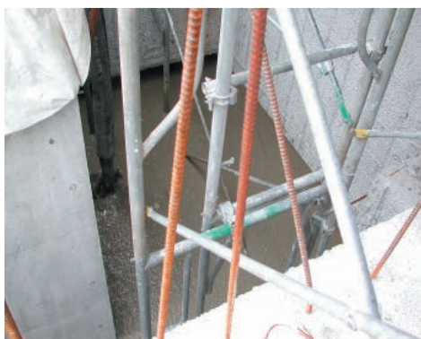
▲ 建築躯体埋め戻し 狭隘部充填工
