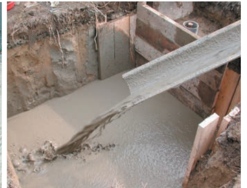
▲ ガス管理め戻し工
