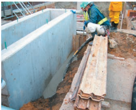
▲ 共同溝 躯体埋め戻し工
