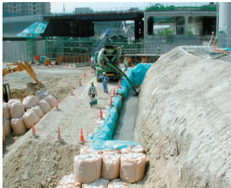
▲ 土留め・盛土工 (カルバート底部)
