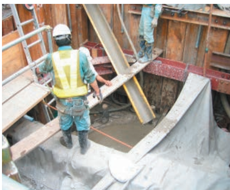
▲ 名高速ピア基礎の側部埋め戻し工
