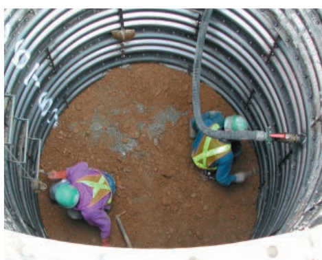
▲ ライナー裏詰め充填工 [エアモルタルの代用]
