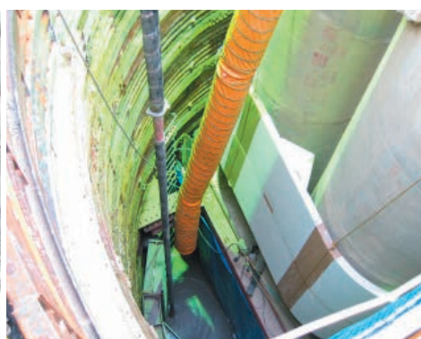
▲ シールド到達部の土留め防護工
