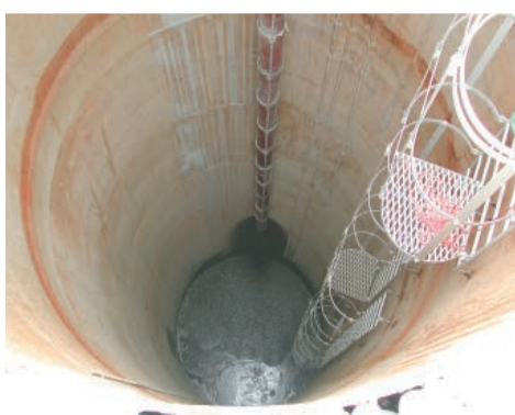
▲ 下水シールド通過立坑埋め戻し
