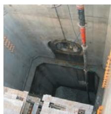
立坑埋め戻し
