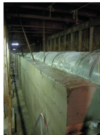
▲ 下水道管下の埋め戻し工 (完了)
