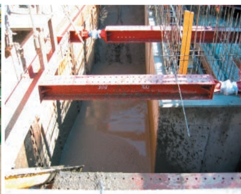
▲ 共同溝 躯体埋め戻し
