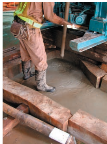
▲ 地下空隙部充填工
