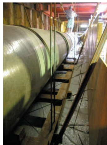
▲ 下水道管下の埋め戻し工 (打設状況)
