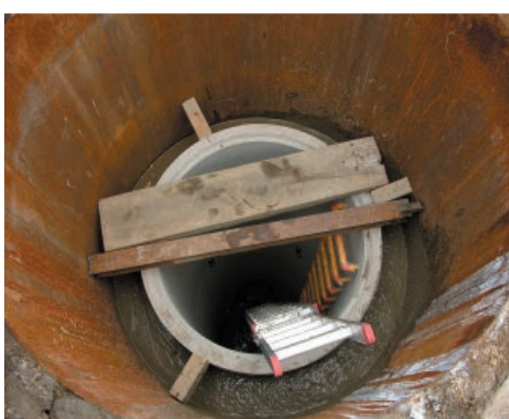
▲ 人孔周囲の充填工 (H 鋼による浮力防止措置)
