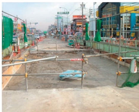
▲ 換気口周囲の埋め戻し（路盤として打設）
