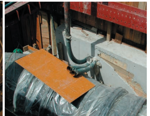
▲ 廃管渠充填工 L=30m, φ1650
