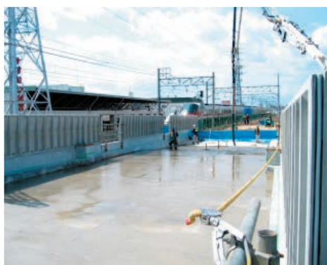
▲ 盛土工 (打設後の最終整形)
