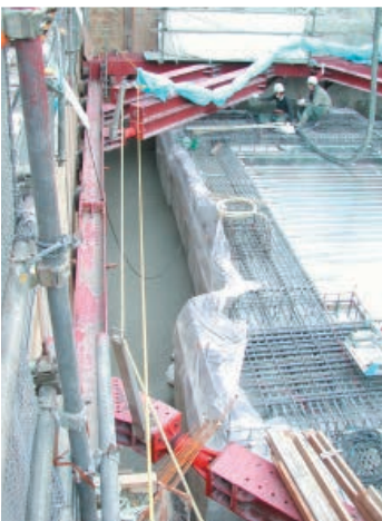
▲ 建築基礎部分の埋め戻し
