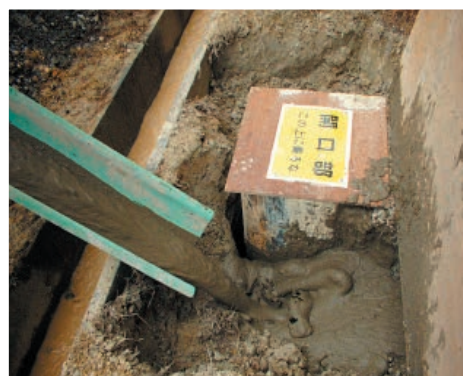
▲ 鋼柱周囲の充填 (遮音壁基礎部分)
