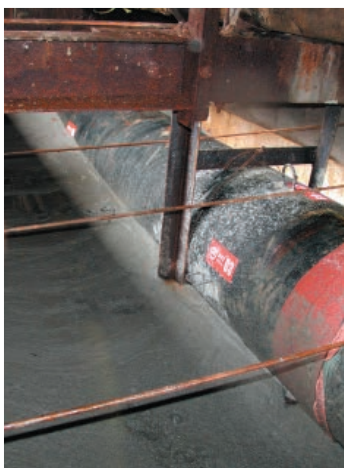
▲ NTT 管埋め戻し (施工振動不可部)
