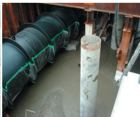
▲ 取水管の受防護工
